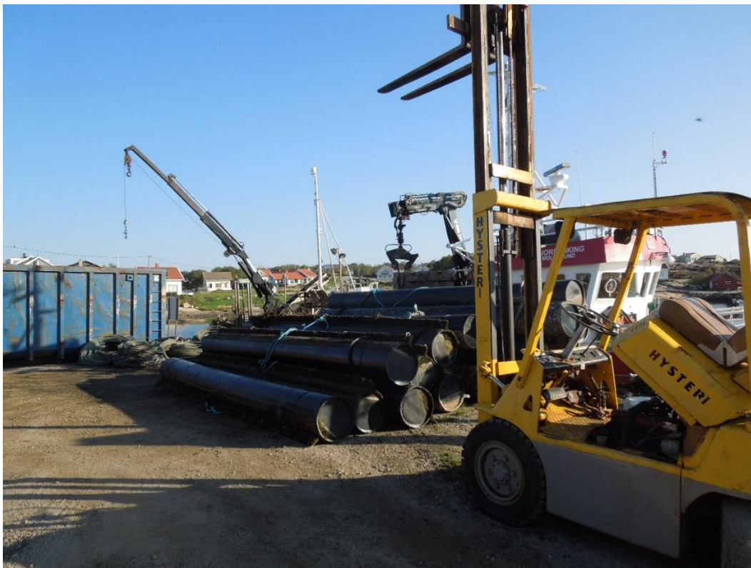
Fortøyningsrør tatt på land. Foto: Scanfjord Mollösund AB.
