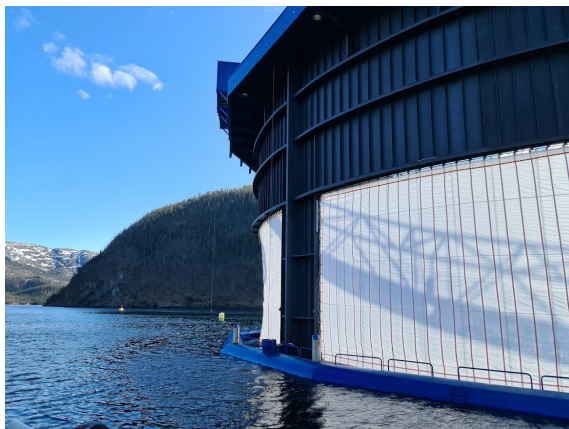
Figur 41: Aquatraz 4 påmontert 10 meter presenningsskjørt i tillegg til den opprinnelige skjermingen med 8 meter stålskjørt.
