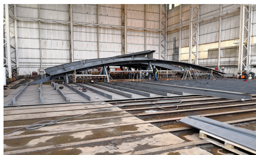
Figur 11: Fabrikasjon av moduler
