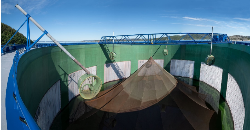
Figur 6.1: Strømsettere (Xylem miksere)
