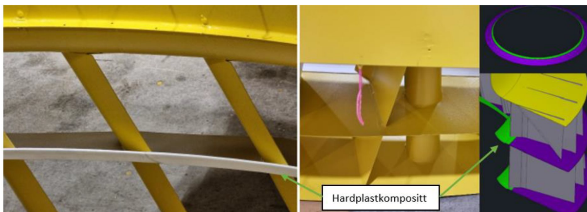
Figur 7. Venstre: 3D-printet kant (hvit). Midten: Søyle gjennom foilseksjon. Høyre: Sammenslåing av 3D-printet- (grønn) og stålmateriale.
