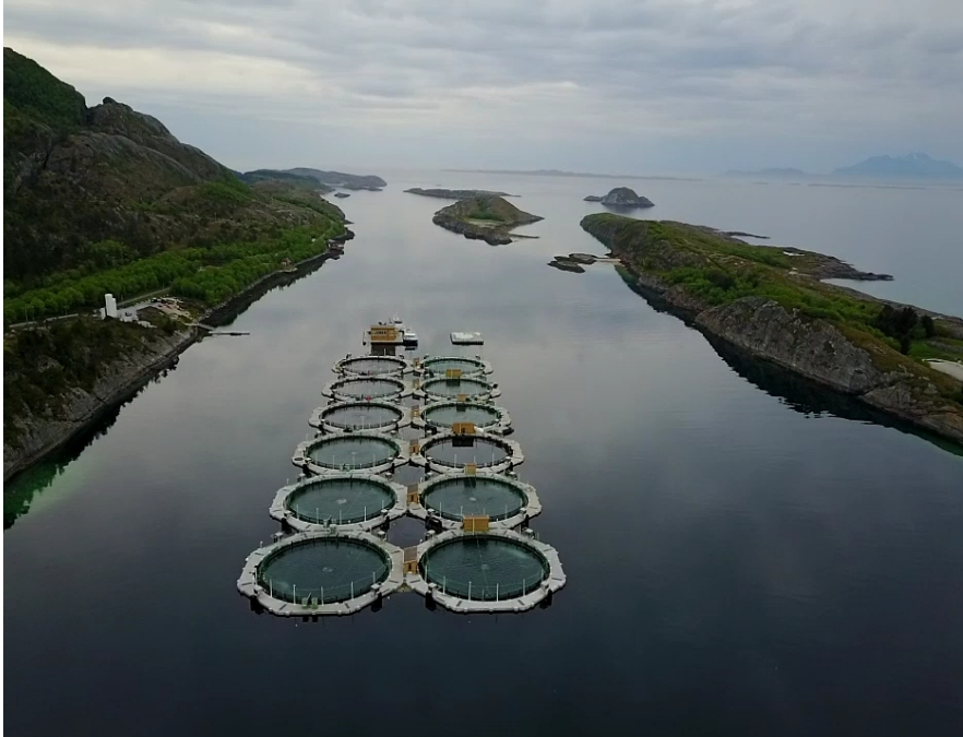
Bilde av ferdig montert lukket anlegg med 12 enheter ved Hamnsundet.
