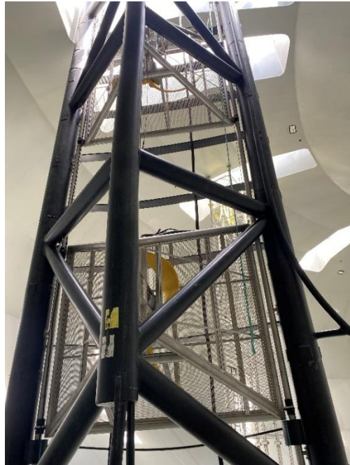
Figur 6: Gitter og øvrig struktur i strømsettertårn, sett skrått nedenfra
