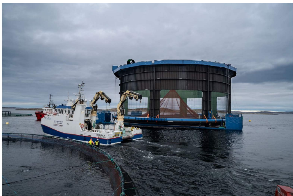
Figur 4 Aquatraz G2-C1 på Aquatraz-lekterne, før installasjon i rammefortøyning Kyrøyan
