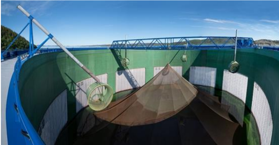
Figur 8.1: Aquatraz G3 med 18 m dypt luseskjørt og 4 stk. strømsettere (Bilde: Steinar Johansen).
