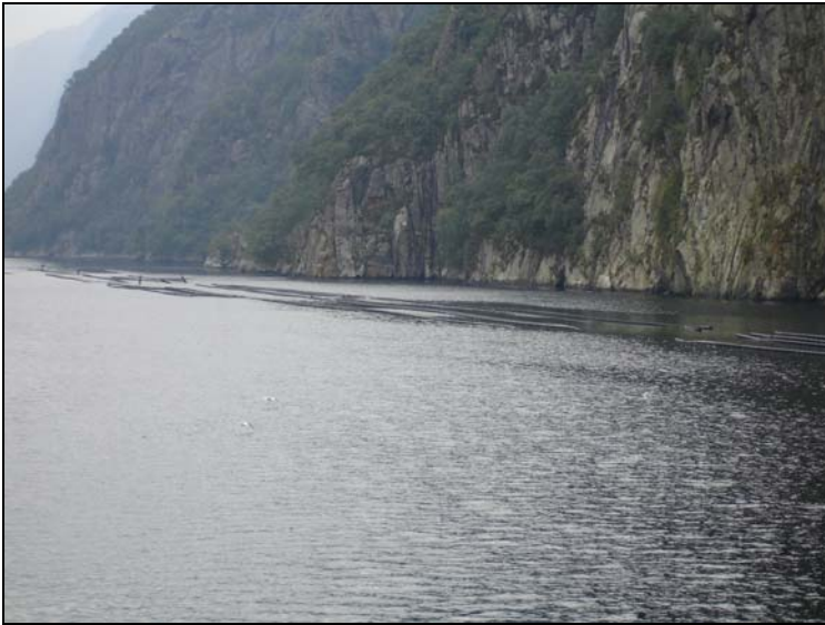
Bilde 5.2.2. Urdgil i Gjesdal, havarett anlegg
