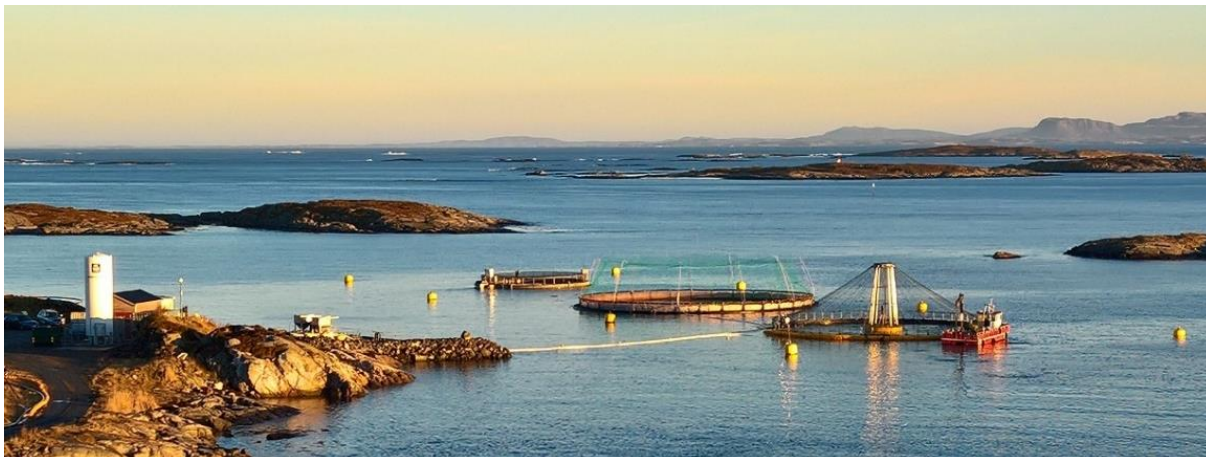
Bilde 1: Oversiktsbilde, Gullklakken. Den minste produksjonsenheten, lengst til venstre i bildet, er betongtanken.
