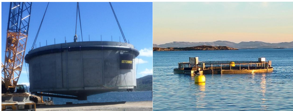
Bilde 2: Betongtanken under sjøsetting (venstre). Betongtanken ferdigstilt og i drift på lokaliteten Gullklakken (høyre).
